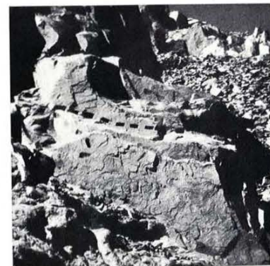
d) Lykabettos-Steinbrüche. Spaltspuren des 1. Jh.s
