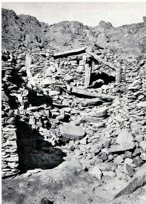
a) MONS CLAUDIANUS — Blick vom zentralen Dreiecksplatz aus auf die Magazinbauten 6 und 7 mit Resten der teilweise abgestürzten Deckenkonstruktionen
