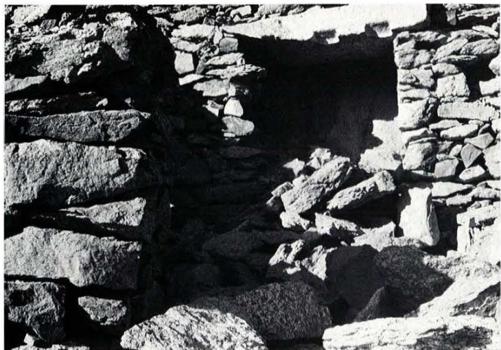
a) MONS CLAUDIANUS — Südwadi: Wächterhaus(?) südlich des Tempels, Blick durch Eingang auf Nische in der Rückwand
