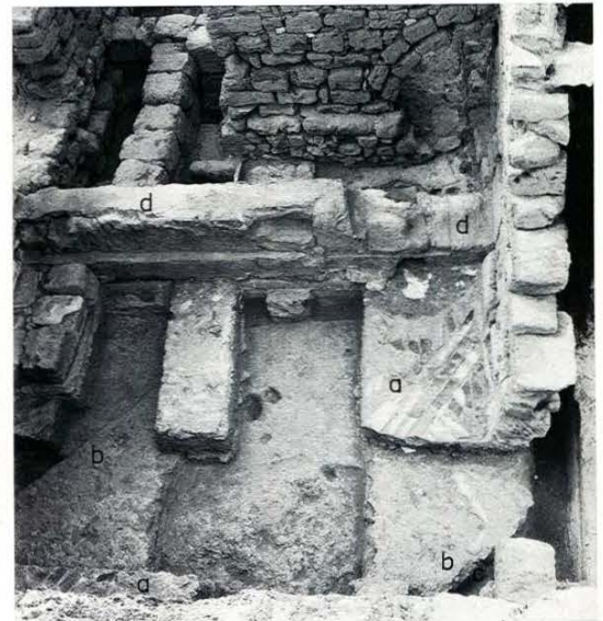
b) ABU MENA — Baptisterium: Einblick in die durch die beiden östlichen Stützmauern gebildete Nordkammer mit Resten des Unterbodens (a), der zementierten Beckeneinfassung (b), der Beckenkante (c) sowie der älteren Nordaußenmauer (d)
