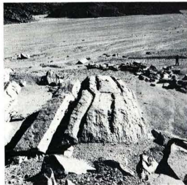
a) Bruch 134. Auf Bruchsohle ausgelegte Einteilung zur Gewinnung von Rohbalken für Säulen
