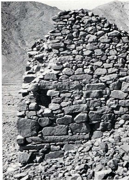
a) MONS PORPHYRITES — Außenfront der Ostmauer mit horizontaler Abgleichung der Bruchsteinschichten im unteren Drittel
